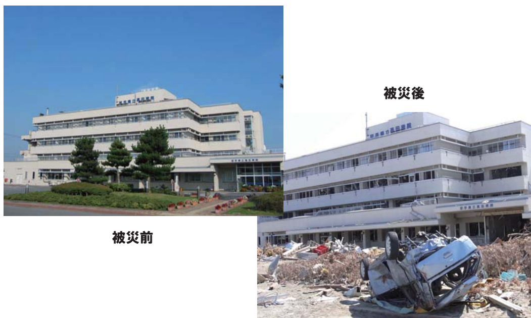
図 3. 被災前後の岩手県立高田病院の様子
