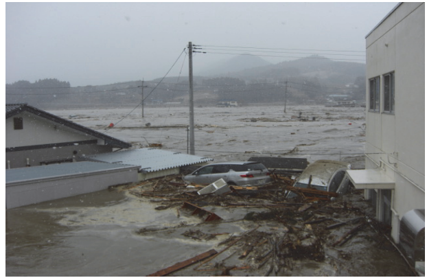
写真②. 病院北側職員玄関付近 (西側：医師住宅)
