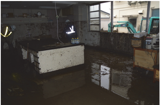
写真⑧. 検査室 (瓦礫撤去作業)
