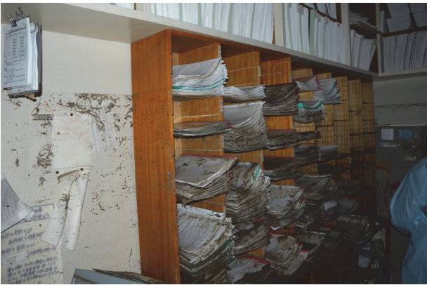
写真⑬. カルテ棚 (このカルテにより薬を処方)
